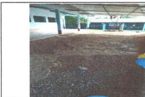
Foto 5: entortado del corredor del modulo 3
