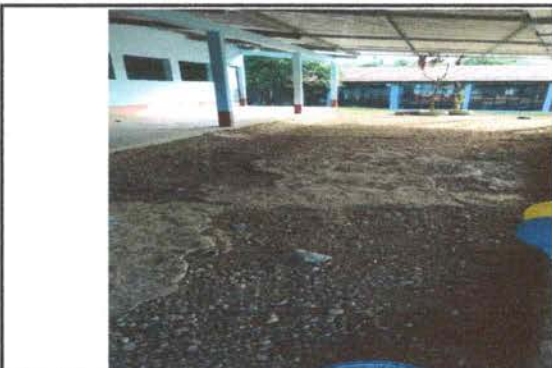
Foto 5: entortado del corredor del modulo 3
